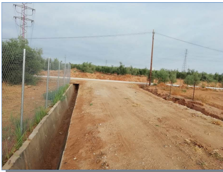
Figura 19. Cuneta perimetral de hormigón junto al cerramiento de la urbanización, en la linde noreste. Se observa que ha sido limpiada recientemente.
