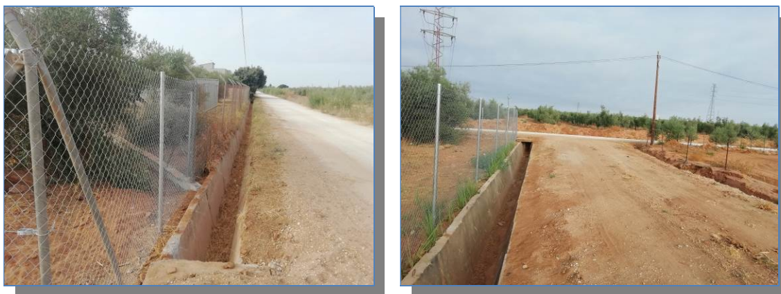
Figura 34. Cuneta perimetral revestida de hormigón que discurre por el perímetro norte de la urbanización, paralela a camino y a la parcela 6 polígono 20 de Bollulos de la Mitación. Se identifica que la cota del camino es más alta que la cota de la cuneta hacia la cual está inclinada, y que la cota del camino es más alta que la cota de las parcelas de la urbanización
