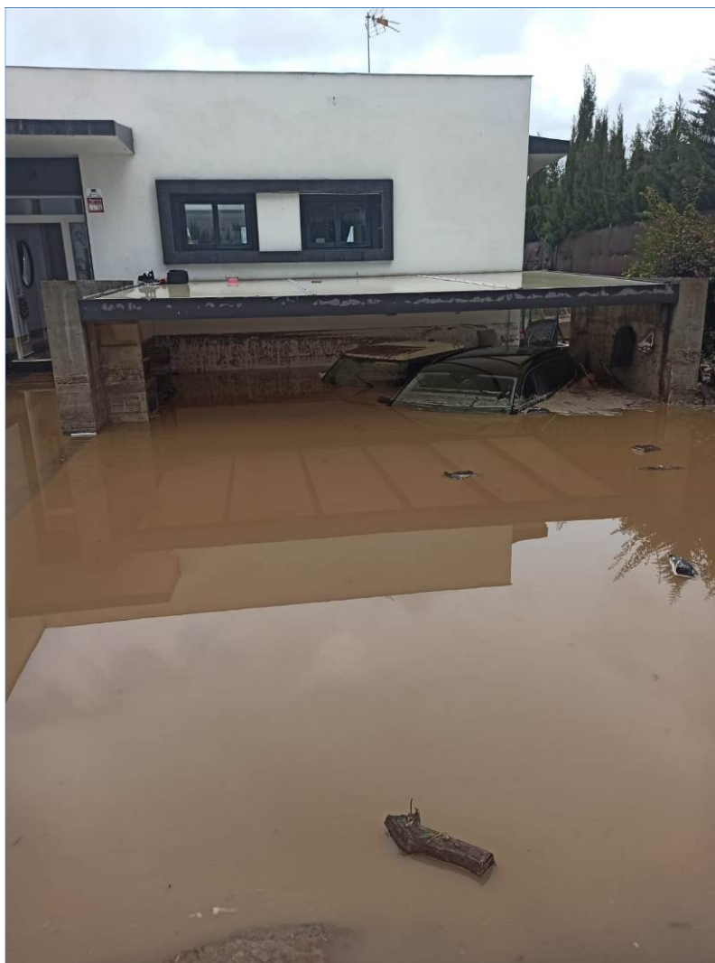
Figura 20. Vivienda de la parcela con dirección c/Jaranda nº4. Inundación de la planta baja
