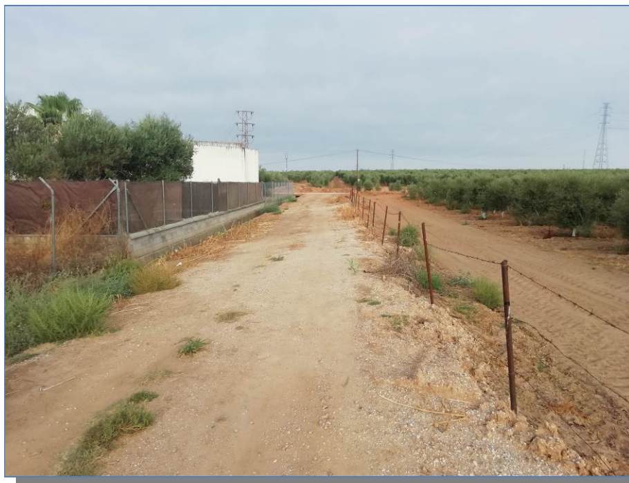
Figura 35. Cuneta perimetral de hormigón que discurre por el perímetro norte de la urbanización, paralelo a camino y a la parcela 6 polígono 20 de Bollullos de la Mitación. Se identifica una diferencia de cota entre el camino hacia la cuneta de hormigón y las parcelas urbanas de la linde noroeste, las cuales está más bajas
