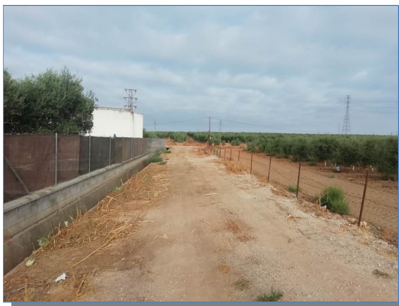
Figura 34. Cuneta perimetral revestida de hormigón que discurre por el perímetro norte de la urbanización, paralela a camino y a la parcela 6 polígono 20 de Bollulos de la Mitación. Se identifica que la cota del camino es más alta que la cota de la cuneta hacia la cual está inclinada, y que la cota del camino es más alta que la cota de las parcelas de la urbanización
