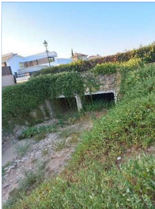
Figura 45. Situación actual del canal a su paso por el puente sobre calle Acebuche.
