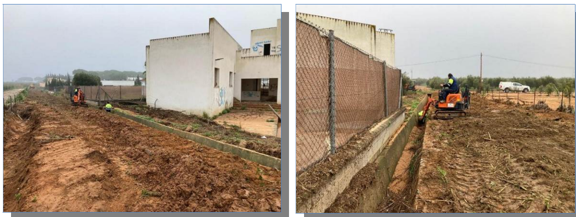
Figura 36. Trabajos de limpieza de la cuneta perimetral de la urbanización La Juliana, tras la avenida de agua que provocó la inundación de la misma
