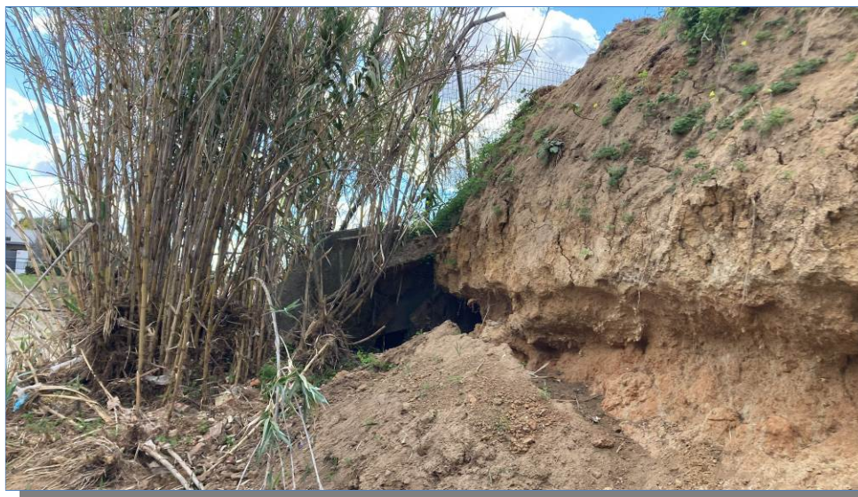
Figura 22. Cauce del arroyo de la Norieta, aguas arriba del encauzamiento hormigonado dañado por efectos de la erosión
