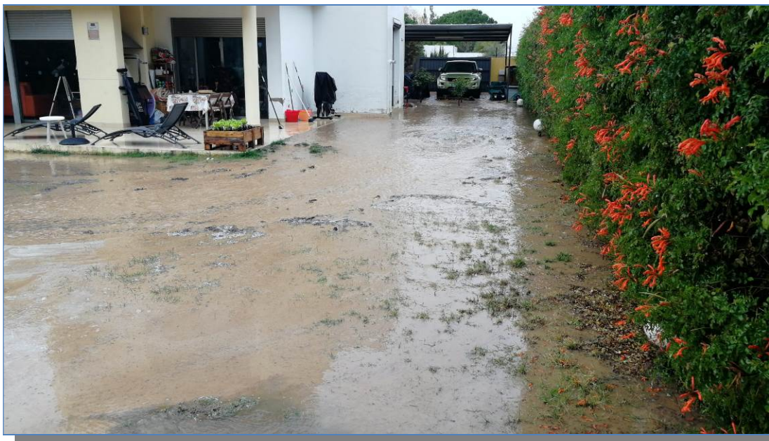
Figura 24. Parcela inundada de la urbanización La Juliana por la avenida procedente del arroyo de la Norieta y del arroyo innominado
