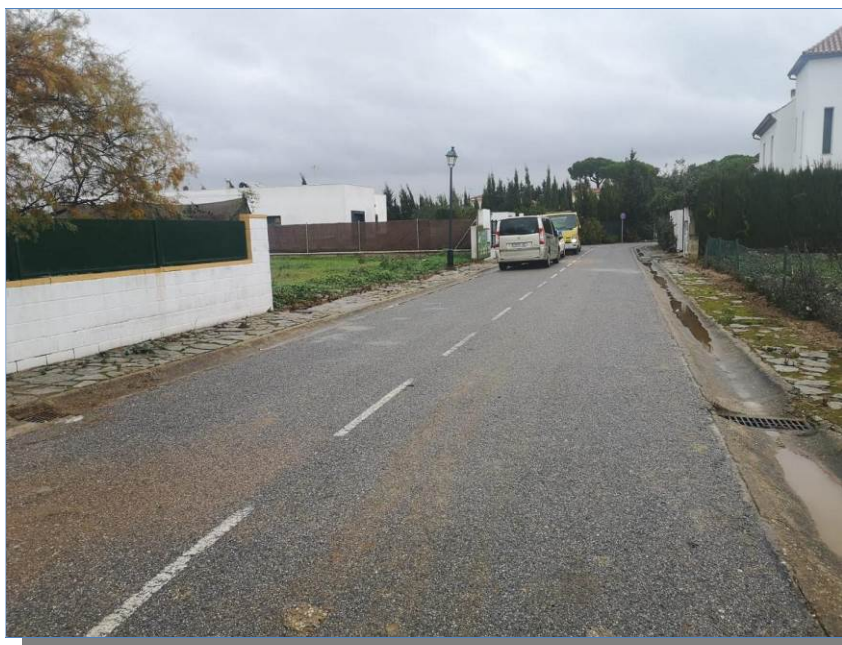
Figura 44. Vial de la urbanización limpiado, en el cual se limpió fango y restos de material de la inundación
