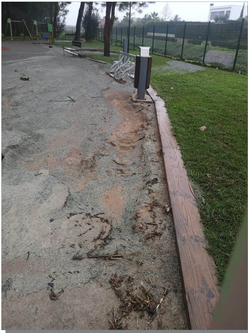
Figura 27. Daños en parque infantil de la urbanización La Juliana
