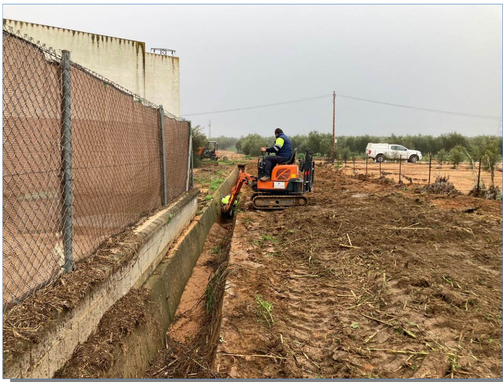
Figura 46. Limpieza de la cuneta perimetral existente en el norte de la urbanización
