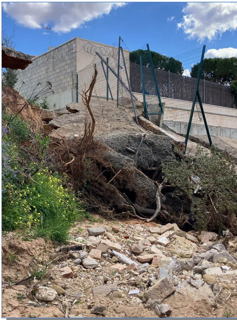
Figura 22. Cauce del arroyo de la Norieta, aguas arriba del encauzamiento hormigonado dañado por efectos de la erosión
