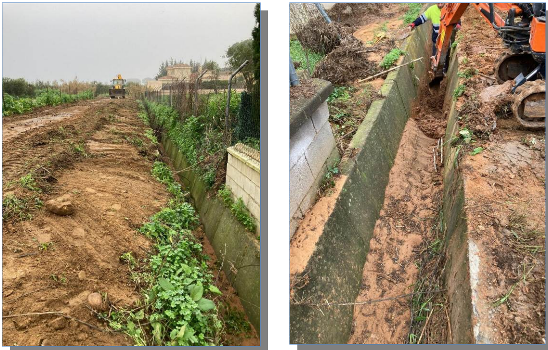
Figura 37. Trabajos de limpieza de la cuneta perimetral de la urbanización La Juliana, tras la avenida de agua que provocó la inundación de la misma
