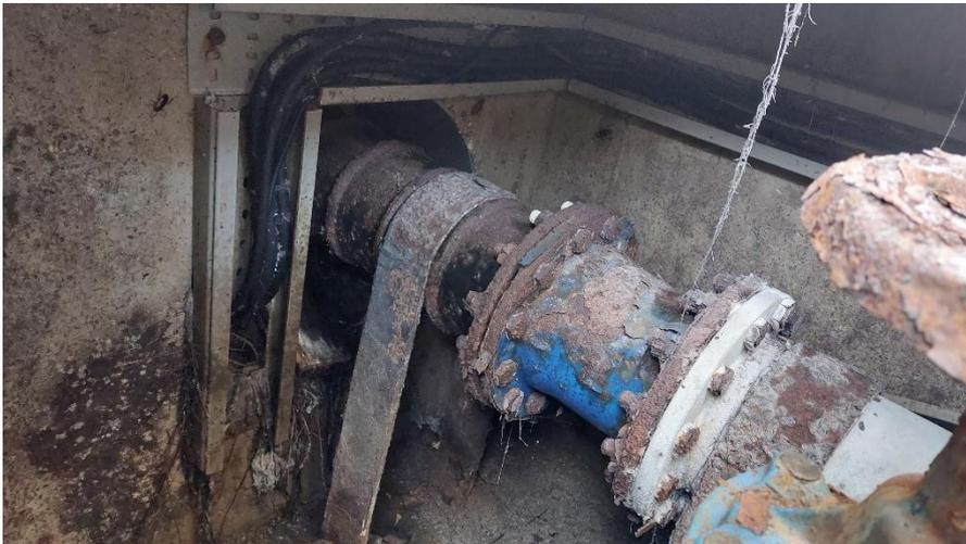
Igualmente, la conexión a la tubería embutida en el prisma se encuentra muy dañada, observándose como el residuo escapa por las fisuras que presenta en la unión con la brida, ante la posibilidad de provocar un daño mayor, se decide no retirar este residuo que actúa como tapón.
