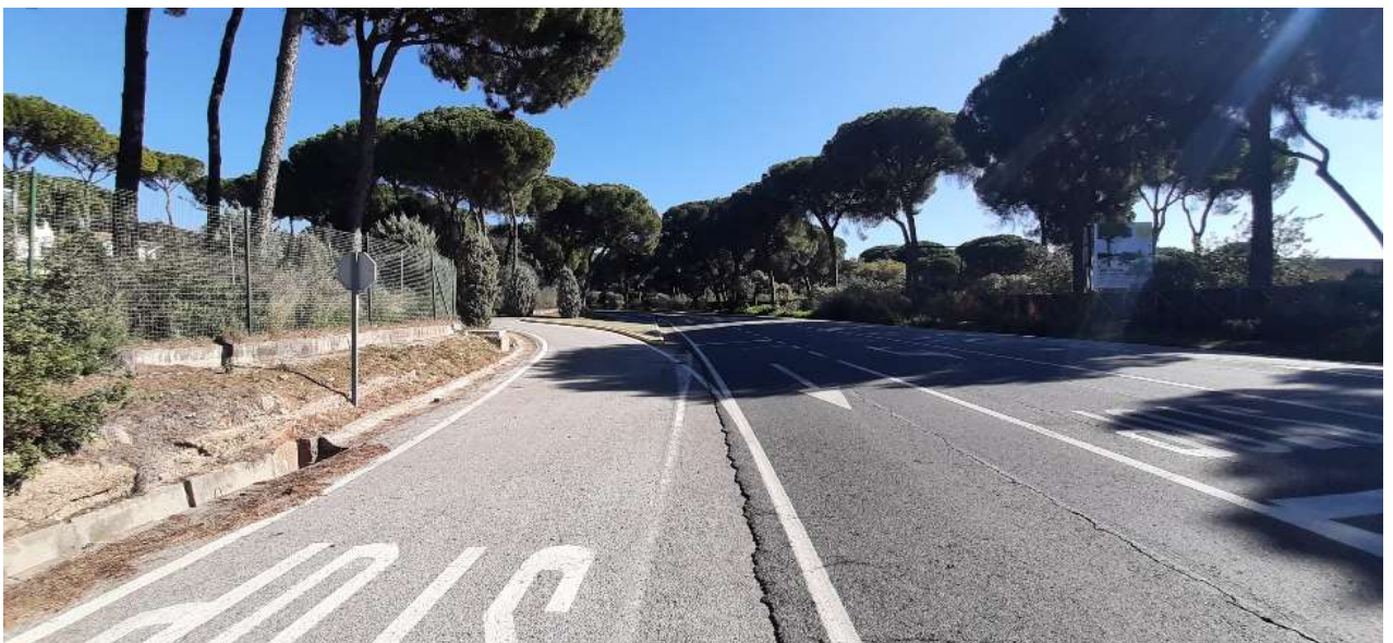
Vista del ramal de incorporación del acceso clausurado y marca vial de STOP desde donde realizamos las medidas de visibilidad disponible en ambos sentidos.
